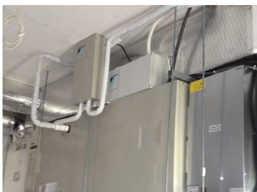
Rys. 7-8. Przykład zastosowania jednostki ERQ200AW1 w nowym obiekcie do współpracy z instalacją nadmuchiową ogrzewania i klimatyzacji
